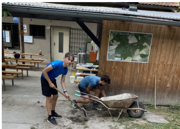
Kolda s Myšákem kopou kanálek. (31. 7. 2024)
